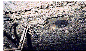
Flocage de plafond
