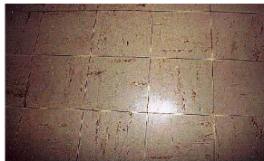
Dalles de sol
